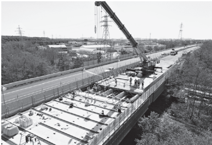
プレキャストPC床版架設状況
