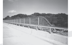
複合防護柵(半壁高欄) 高速道路の橋梁部路側コンクリート遮蔽物に代わる眺望性に配慮した高欄です。
