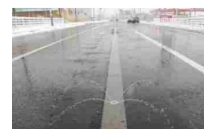
消融雪施設等の整備
