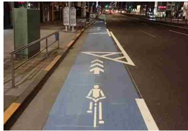
(国道246号:青山地区)
