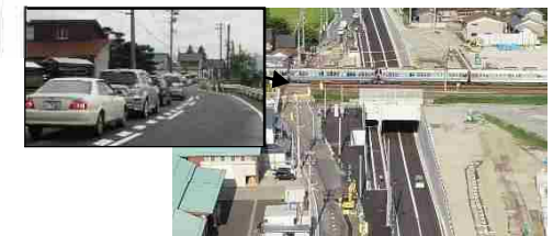
単独立体交差化による渋滞解消 (半田踏切道（福井県福井市）) ※踏切は既に閉鎖しており、今後除却予定
