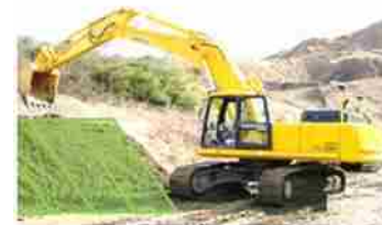
ICT施工の活用
