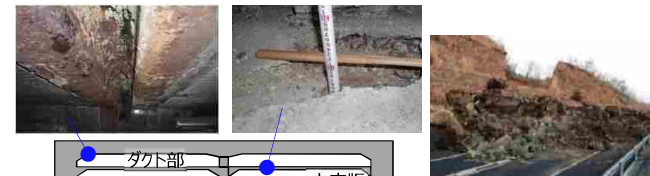
ダクト部 中床版 ＜首都高速 羽田トンネルの状況＞
