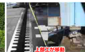
上部工が移動 令和4年3月福島県沖地震 （国道399号（伊達橋）：福島県）
