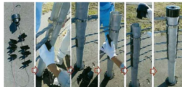
飛散防止ワイヤを付けた状態で、支柱・ワイヤローブ施工後の装着が可能
